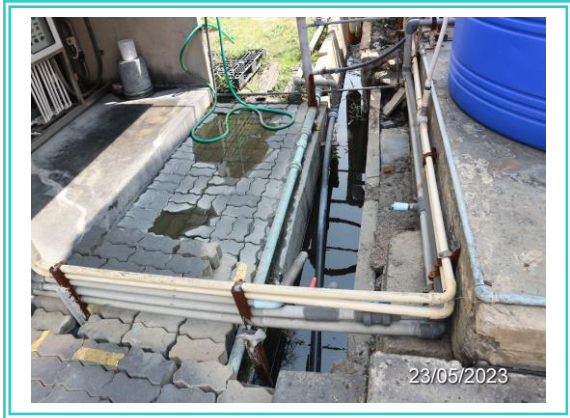
รูปที่ 3-7 รางระบายน้ำที่จากท่อหล่อเย็น
